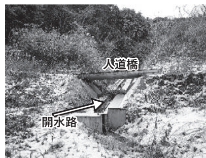
図5 人道橋設置事例(廃止ため池F)
