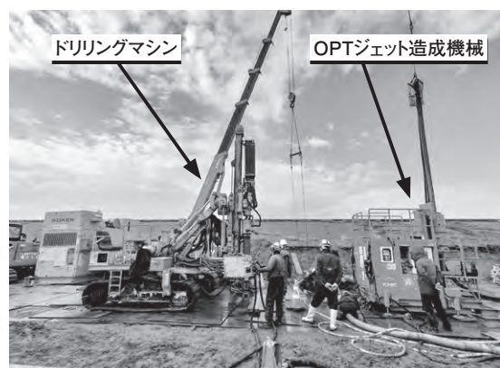
写真4 OPTジェット工法の施工状況－1
