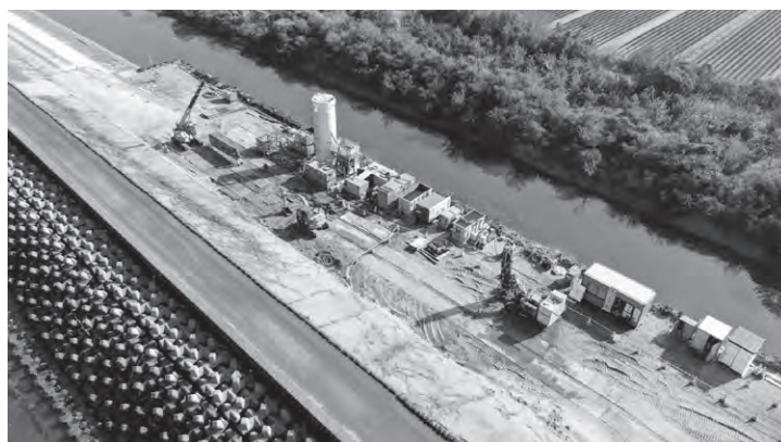
写真5 OPTジェット工法の施工状況－2
