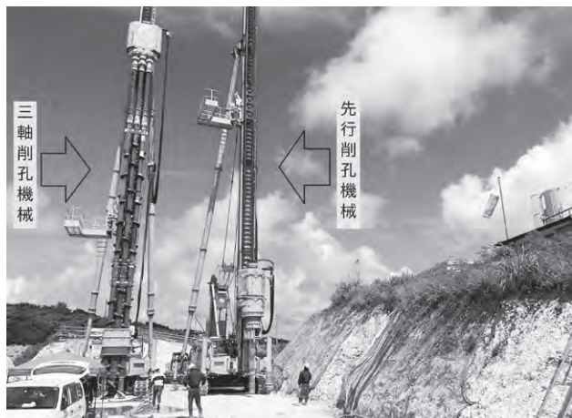
写真1 止水壁の施工機械
