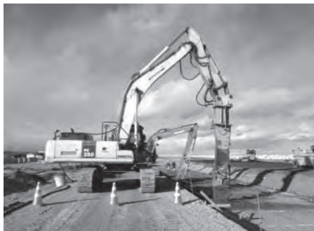
写真3 仙台南部海岸での施工状況
