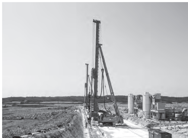
写真2 止水壁の施工状況
