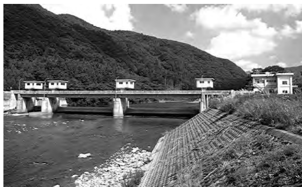
早出川頭首工(下流より望む)
