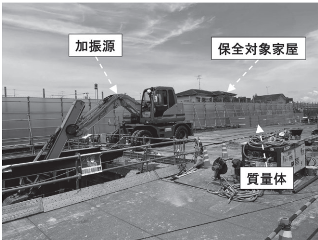
図3 質量体の現場適用状況
