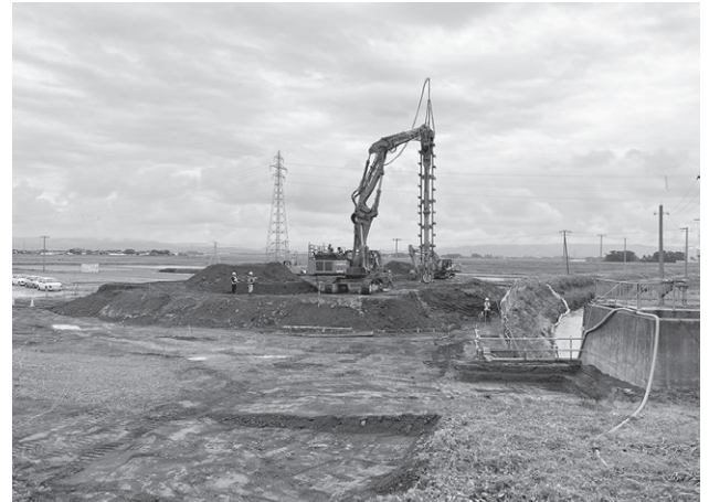
パワーブレンダー状況
