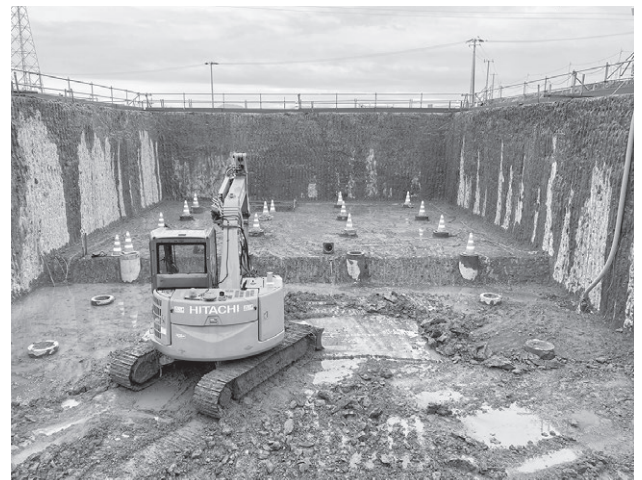
パワーブレンダー後掘削状況
