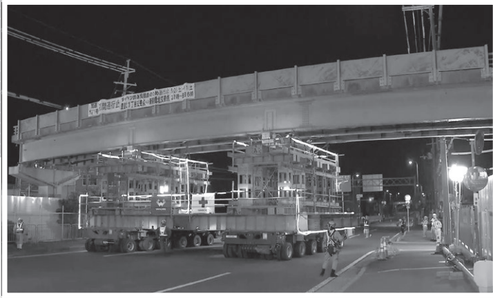
陸橋一括撤去状況
