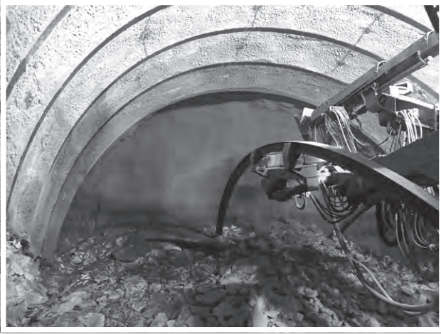
新幹線トンネル現場の切羽の様子
