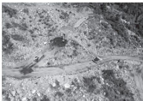
図5 実施工検証状況 (現場)
