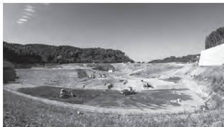
図8 実施工検証状況 (現場)
