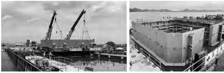
写真3 仮締切水上組立状況
