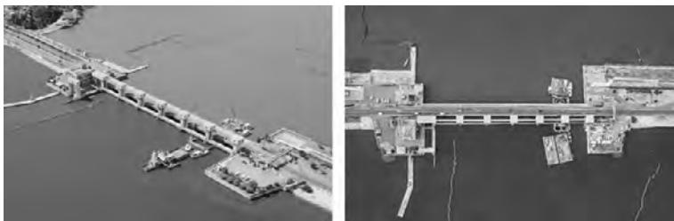
写真7 児島湾締切堤防排水樋門改修工事 施工状況
