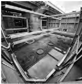
写真5 仮締切内ドライアップ
