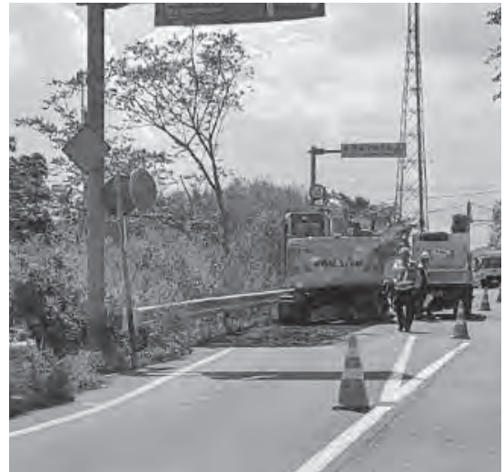
図1 盛岡市南部地区の埋設管改修工事
