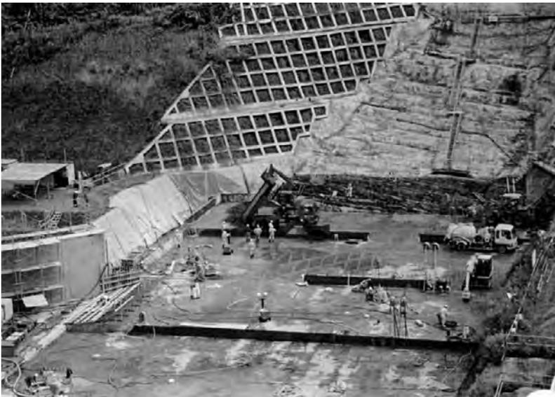
ダンプ直送による拡張レヤ打設状況
