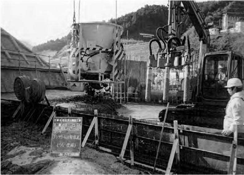
ケーブルクレーンによる拡張レヤ打設状況
