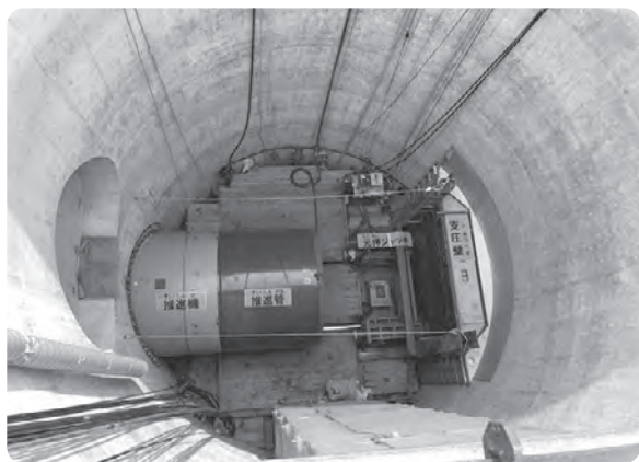
写真1 発進立坑から推進管を挿入
