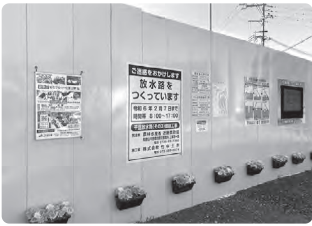
写真4 工事現場での掲示の状況
