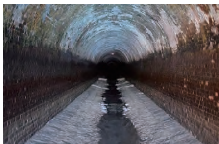
【隧道（第二号水路中間部）】
