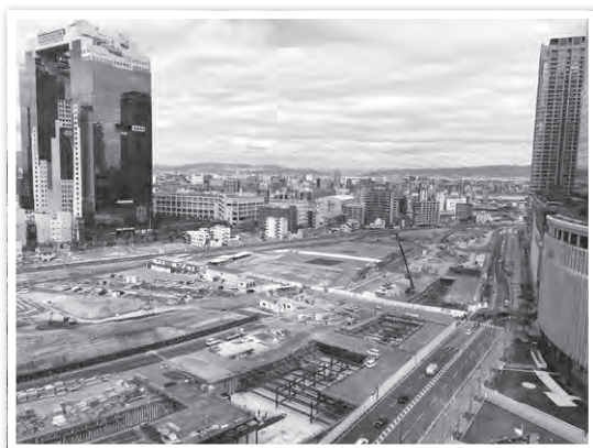
うめきた地区の地下構造物工事
