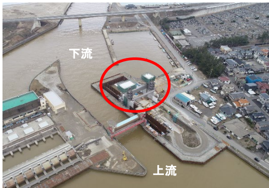
右岸側施工中（2023年2月撮影）
