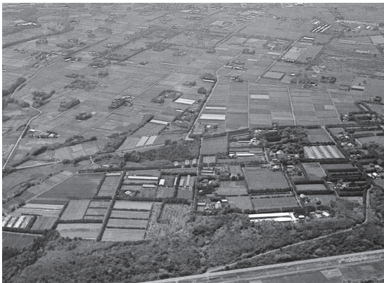
国営高鍋川南開拓建設事業(「宮崎県土地改良史」から)
