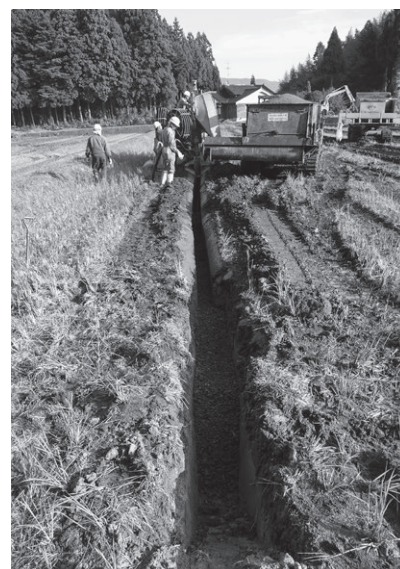
図4 暗渠管の埋戻し材
