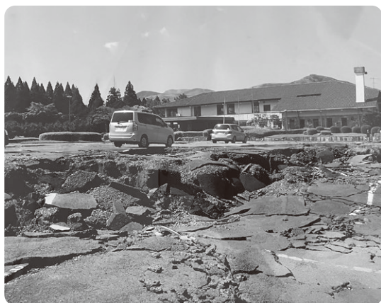
1mを超える段差の発生とクラブハウスの全損
