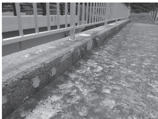
写真1 側道橋地覆の施工前劣化状況
