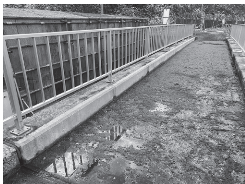
写真4 側道地覆の施工後（7年2か月後）状況
