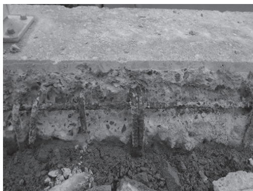
写真2 はつり取り後の鉄筋状況
