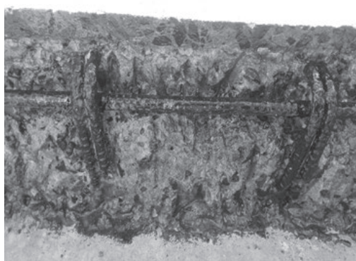
写真3 塩分吸着型エポキシ樹脂塗布後の状況
