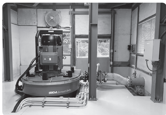
写真6 新設水車発電機
