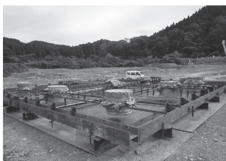
写真2 均しコンクリート型枠
