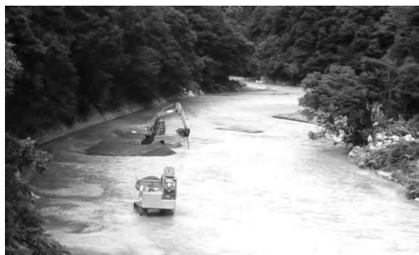
写真3 水陸両用バックホウ水中掘削積込み、水陸両用クローラダンプ水中運搬状況
