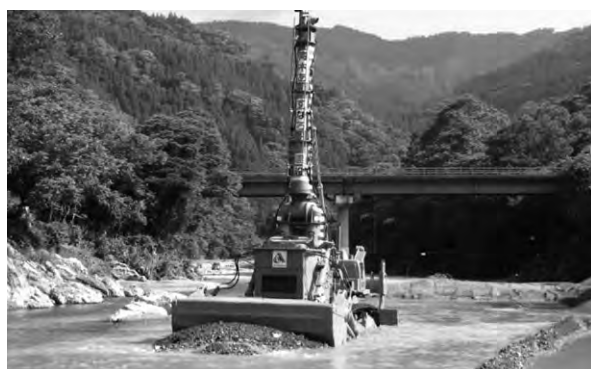
写真2 水陸両用ブルドーザ水中掘削押土状況
