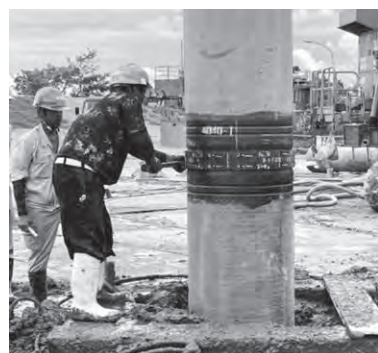
写真2 機械式継手の施工状況
