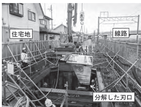
写真5 刃口の分割回収状況
