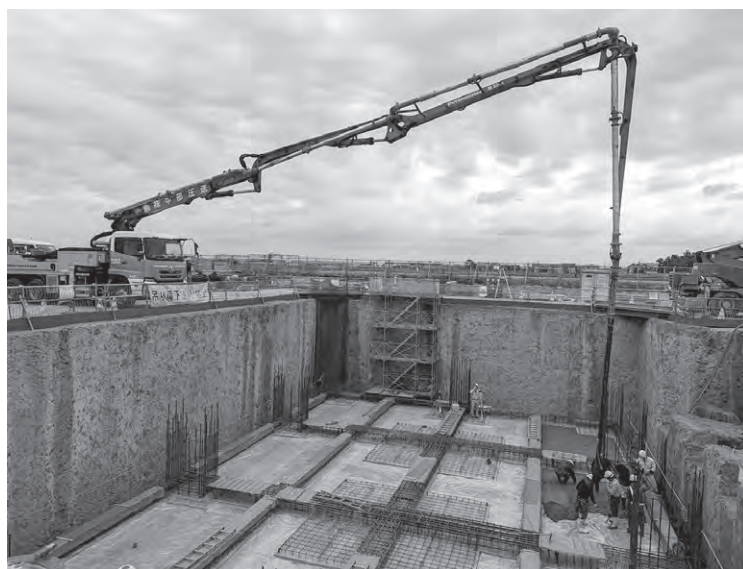
パワーブレンダー工法で確保した開放感のある土留壁内での作業状況
