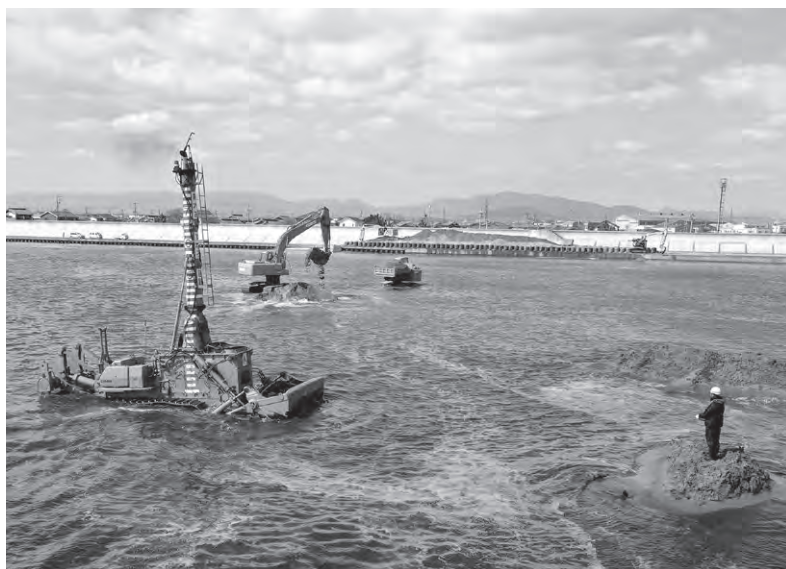
「水陸両用ブルドーザ」による浅水域での施工状況
