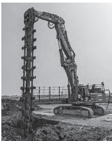
パワーブレンダーによる土留壁の構築状況 (最大改良深度12.5m)
