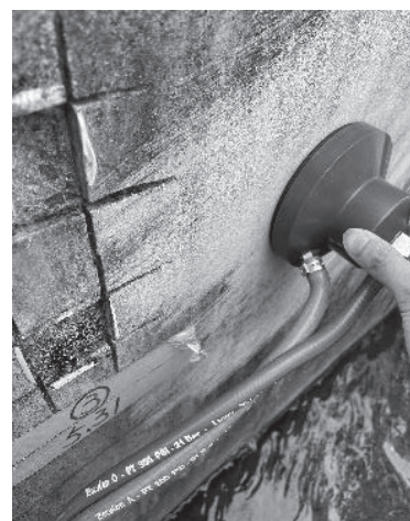
写真1 表層透気試験の様子
