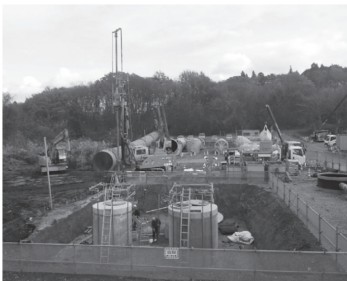
本件工事現場(導水路を地下トンネルに接続)
