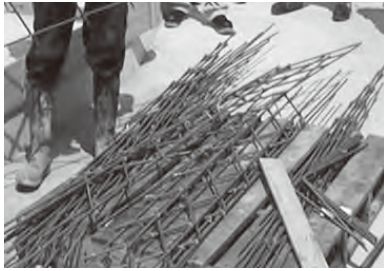
写真3 折り畳んだ状態のユニット鉄筋
