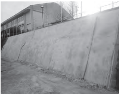
写真9 吹付完了後の状況
