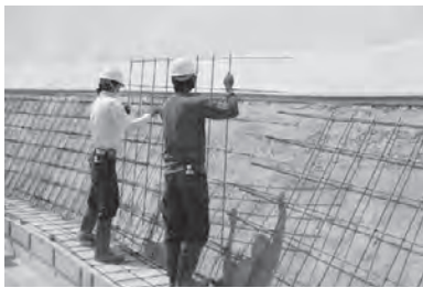
写真5 ユニット鉄筋組立状況
