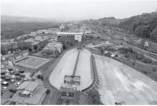
写真6 広桃沈砂池水砂完了全景
