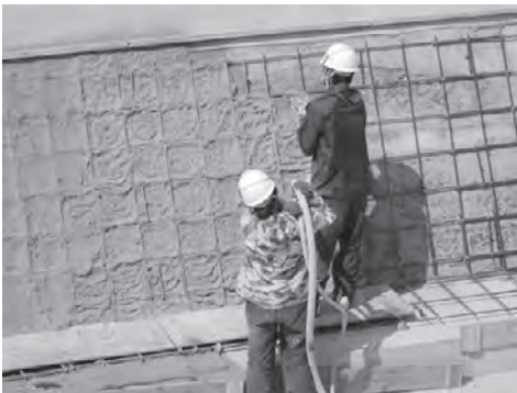
写真1 LCモルタル吹付け
