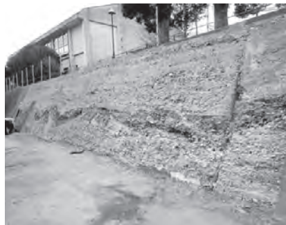
写真8 チッピングおよび高圧洗浄後の状況
