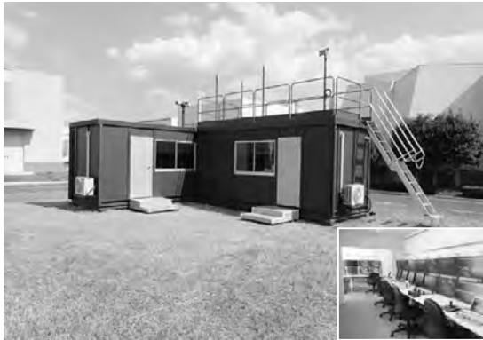
写真1 拡張型高機能遠隔操作室
