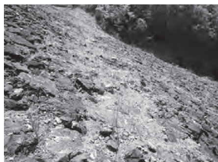
図1 西原ダムのリップラップ材料の細粒化
