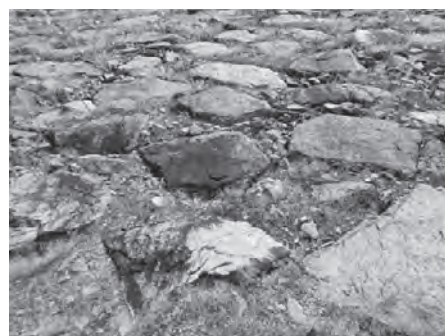
図2 下蚊屋ダムのリップラップ材料の変色
