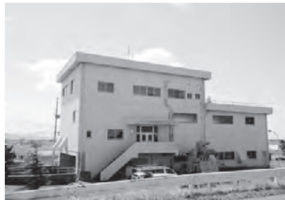
改修を待つ車場揚水機場
