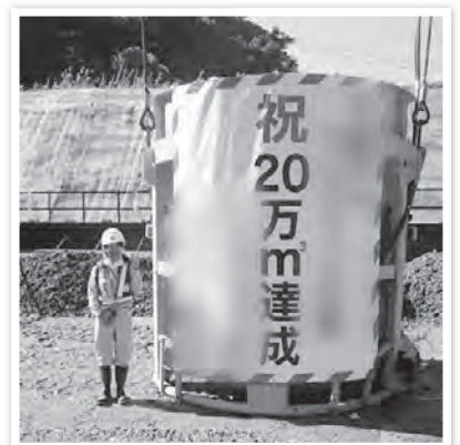
ダム現場では、バケツを用いて打設します。打設量の節目ごとに式典を行いました。
