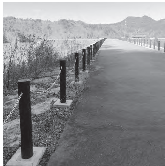
写真1 大柿ダム堤体天端写真
