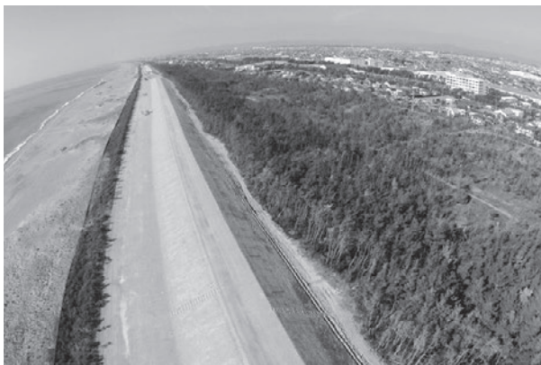
図6 防潮堤完成箇所
