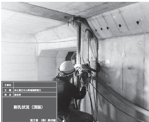
写真1 ベストグラウトバー施工状況
