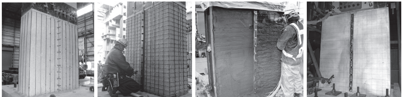
(a) 軸方向鉄筋の設置 ※RC曲げ補強工法のみ
