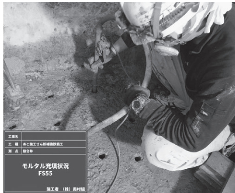
写真1 ベストグラウトバー施工状況
