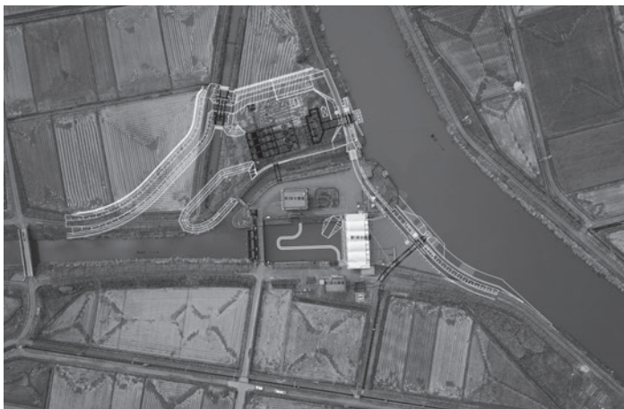
工事着手前の旧木山川排水機場（平成27年10月撮影）
