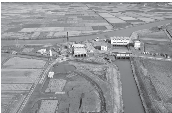
工事施工中の旧木山川排水機場（平成29年2月木山川上流より撮影）
