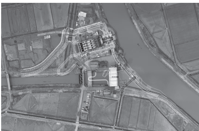
工事施工中の旧木山川排水機場（平成29年2月撮影）
