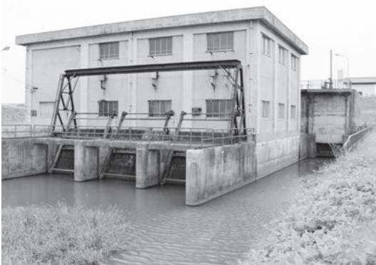
写真1 現況の毒蛇排水機場
