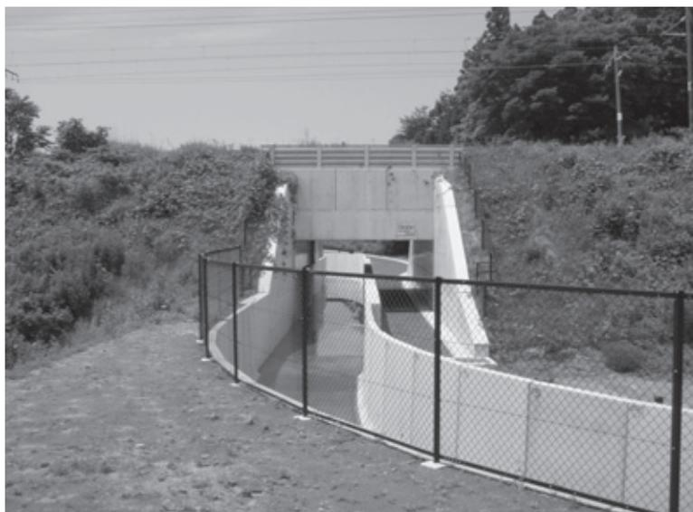
写真2 東北本線直下の水路工事
