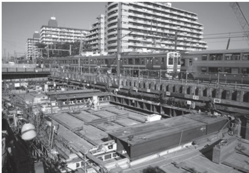
写真1 地盤切削JES工法による施工状況
