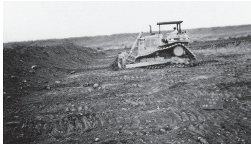
汚染土の剥ぎ取り(「公害防除特別土地改良事業 神通川流域地区」から)
