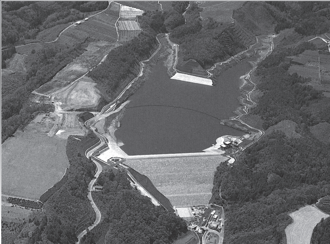
国営かんがい排水事業によって築かれた東伯地区の西高尾ダム（「畑地農業と水」から）
