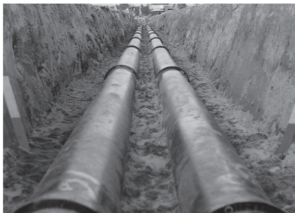
パイプラインの埋設（「畑地農業と水」から）
