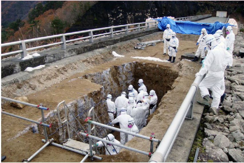
東北大地震で被災した福島県大柵ダムの試掘調査
