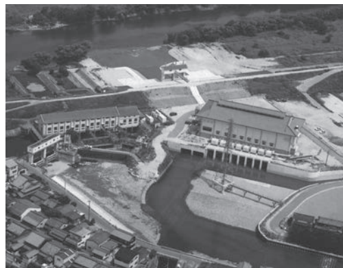
上が淀川、左・旧排水機場、右・新排水機場(パンフ「巨椋池」から)
