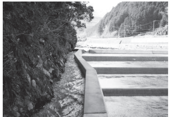
右岸用水路（静岡県提供）
