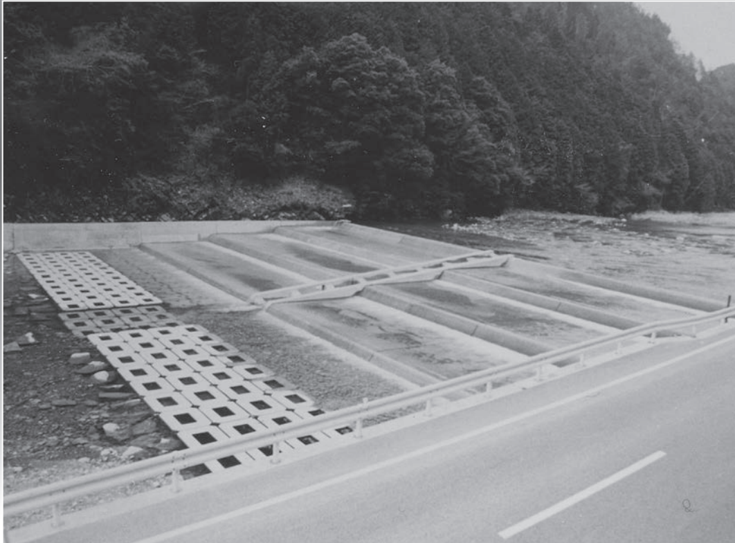
和田島頭首工(静岡県提供)
