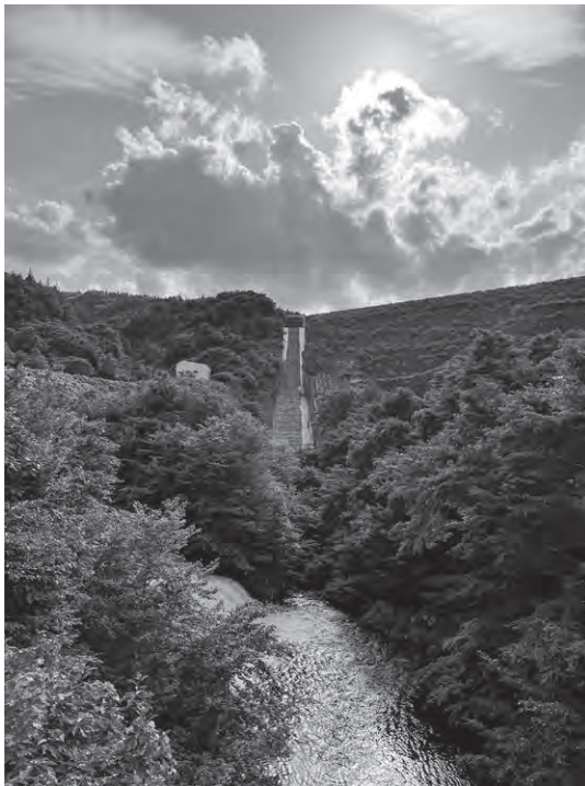
荒砥沢ダム下流から堤体、洪水吐を臨む 左からの流れ込みは、小水力発電の放流水
