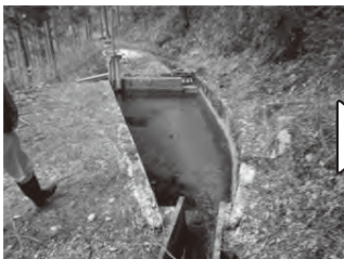
沈砂池の増設
