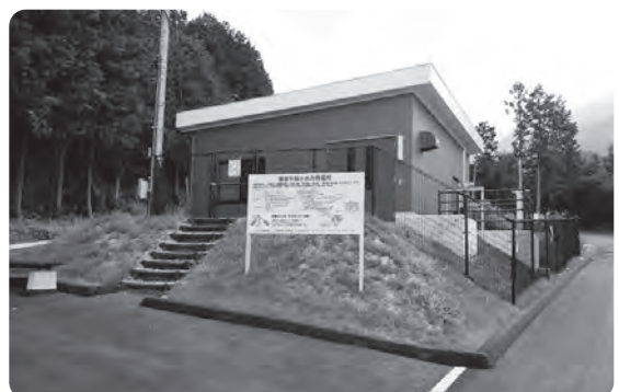
発電所建屋 (内部に水車等を設置)
