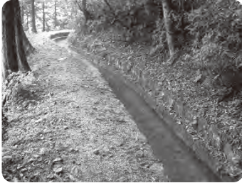
上：かんがい取水口 下：既存の導水路
