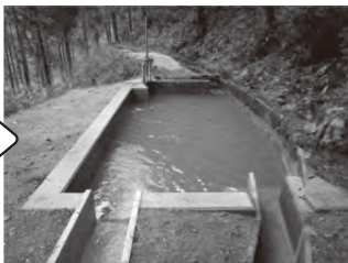
沈砂池の増設
