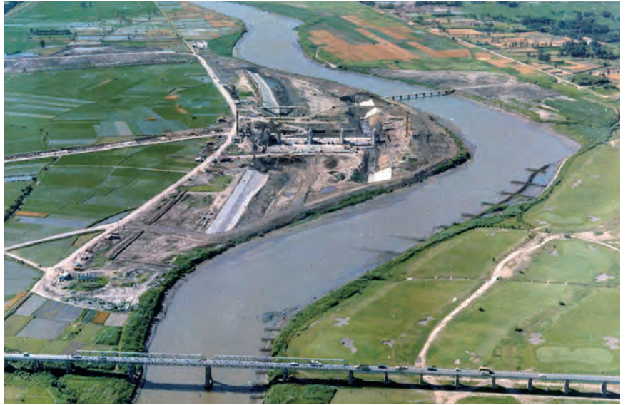
建設中の秋ヶ瀬取水堰
