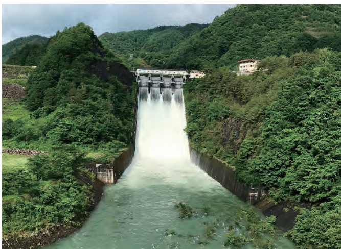
洪水吐からの事前放流を行う牧尾ダム
