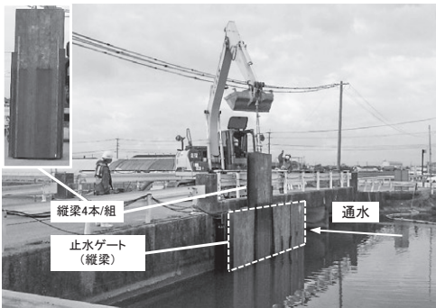
図5 仮設ゲート 施工写真
