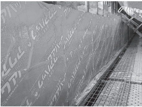
写真3 コンクリート湿潤養生シート
