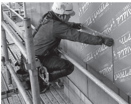
写真2 貼り付け状況
