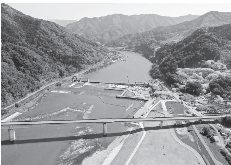
工事中の遙拝頭首工と八の字堰（ドローン）
