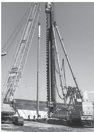
杭建込み状況
