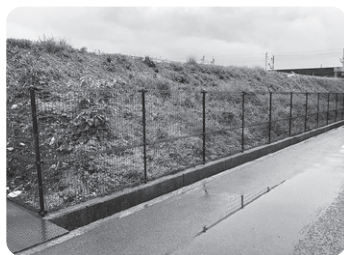
写真4 ネットフェンス設置
