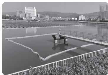
写真3 取水口まわりのダストフェンス設置
