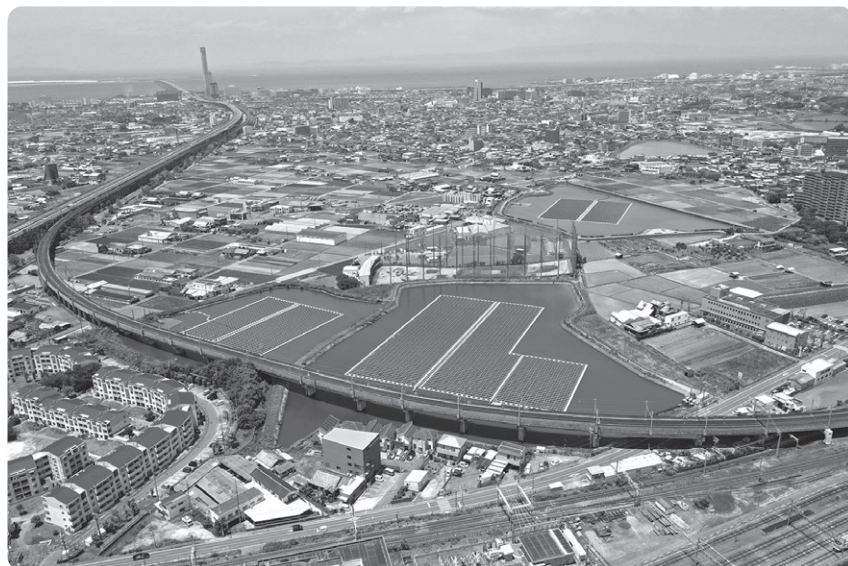
写真2 泉佐野市長滝第1・第2発電所
