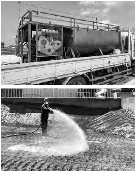
写真5 ハイドロシールドと本粉じん抑制技術の施工状況
